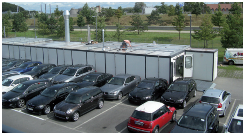
Photovoltaik-Installation auf dem Flachdach
