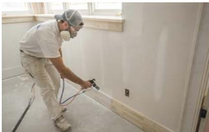
Die FinishPro™ ist ideal für größere Finish-Anwendungen. Die FinishPro™ wurde mit einer Vielzahl von Grundierungen, Lacken und Dispersionsfarben erfolgreich getestet. Die Anwendung kann direkt aus dem Materialeimer erfolgen. Das ideale Gerät für Lackierarbeiten von z.B. Möbeln, Treppen, Zäunen oder Geländern aber auch für Türen, Wände, Böden oder Decken.
