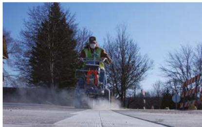
Entwickelt für die Anwendung, konzipiert für den Bediener. Vibrationarme Technologie reduziert Ermüdung während optimale Fräs-Ergebnisse erreicht werden. Unsere GrindLazer kommen in drei Basisversionen mit einer Vielzahl von Frästrommeln.
