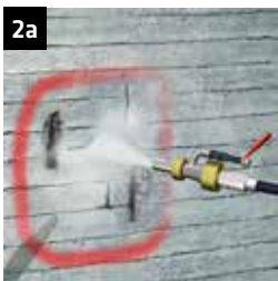
2a Betonabtrag Mit Wasserhöchstdruck 1000-2500 bar
