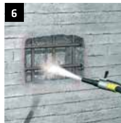
6 Entrosten der Bewehrung Reinheitsgrad Sa 2½
