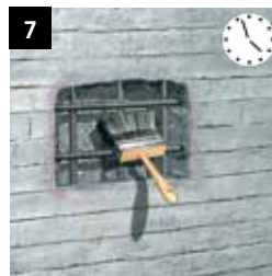
7 Korrosionsschutz der Bewehrung SikaTop Armatec-110 EpoCem Sika MonoTop-910 N insgesamt mindestens 2 x ca. 1 mm
