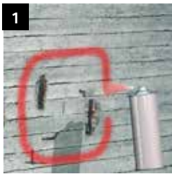
1 Markieren der Reparaturstelle(n)
