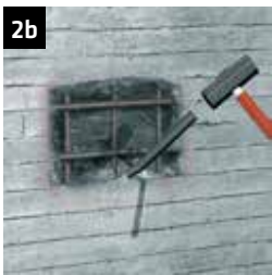
2b Betonabtrag Stemmen
