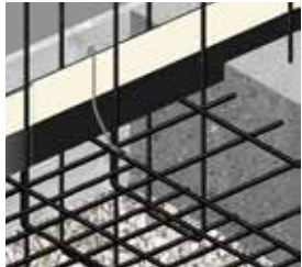
Befestigung an der Bewehrung mit Haltebügeln
