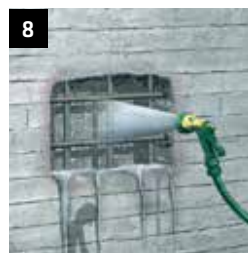
8 Wässern der Betonoberfläche Betonporen mit Wasser sättigen
