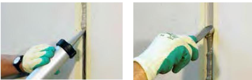
5. Dichtstoff in die Fuge und gegen die Fugenflanken pressen, um eine gute Haftung zu gewährleisten und Dichtstoffoberfläche mit einem passenden Abglättmittel (Sika Abglättmittel) für eine perfekte Fugenoberfläche vor dem Erreichen der Hautbildezeit des Klebstoffs abglätten.
