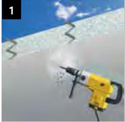
**1** Entfernen von schlechtem Beton oder Holzrückständen und Reprofilieren der Ausbruchstellen
