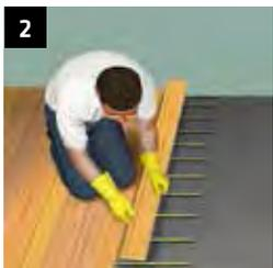
2 Parkettriemen ausrichten und anschließend in den Klebstoff eindrücken. Die Riemen können anschließend mit Hammer und Schlagholz fugendicht zusammengefügt werden. Für die Wandabstände gelten die Angaben des Parkettherstellers. Hautbildezeit des Klebstoffs beachten!
