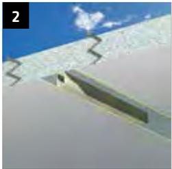
**2** Kontrolle der Ebenheit: maximale Abweichung 5 mm pro 2 Meter
