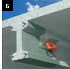
**6** Auftragen des Harzes auf die vorbereitete Oberfläche mit Bürste, Spachtel, Kelle oder Traufel. Materialauftrag ca. 0,7 bis 1,2 kg/m<sup>2</sup>, je nach Rauigkeit der Oberfläche und Gewebetyp.
