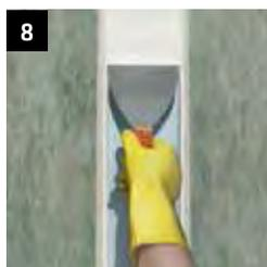
**8** Sikadur® Combiflexkleber CF bzw. Sikadur®-31 AUT Kleber auf das Band auftragen
