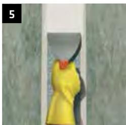
**5** Sikadur® Combiflexkleber CF bzw. Sikadur®-31 AUT Kleber auf Untergrund auftragen, links und rechts der Fuge
