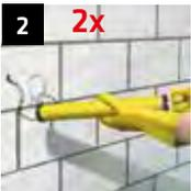
**2 2x** Das Bohrloch vom Bohrlochgrund her mit einer Ausblaspumpe oder mit Druckluft reinigen (mind. 2 x).
