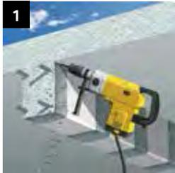
**1** Anbringen der Verankerungsbohrungen oder -schlitze in der Druckplatte
