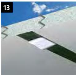
13 Anschleifen der Lamellen (Feinstaubfiltermaske, Schutzhandschuhe und -brille tragen!)
