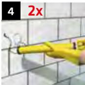
**4 2x** Nach jedem Reinigungsgang ist das Bohrloch vom Bohrlochgrund her mit einer Ausblaspumpe oder mit Druckluft zu reinigen (mind. 2 x).
