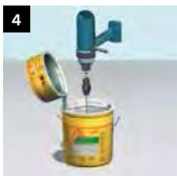
**4** Sikadur® Combiflexkleber CF bzw. Sikadur®-31 AUT korrekt dosieren und mit Mischspindel mischen
