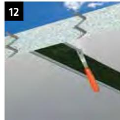
12 Entfernen des überschüssigen Sikadur®-30 Normal mit Spachtel entlang den Lamellenrändern. Keinen Colma-Reiniger oder andere Lösemittel verwenden!
