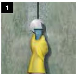
**1** Untergrundvorbereitung mittels Sandstrahlen, Schleifen usw., danach entstauben
