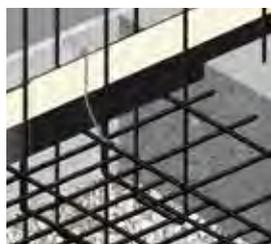
Befestigung an der Bewehrung mit Haltebügeln
