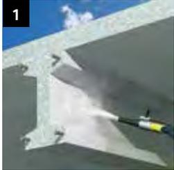
**1** Betonoberfläche sandstrahlen oder schleifen
