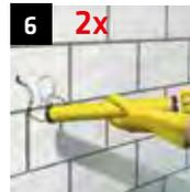
**6 2x** Nach jedem Reinigungsgang ist das Bohrloch vom Bohrlochgrund her mit einer Ausblaspumpe oder mit Druckluft zu reinigen (mind. 2 x).
