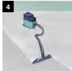
Sobald die Beschichtung begehbar ist, überschüssigen Sand zusammenkehren. Die Oberfläche grundsätzlich entstauben.
