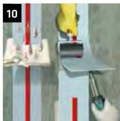
**10** Bandstöße, L-Anschlüsse und Kreuzungen: 4 - 5 cm überlappen, mit Colma-Reiniger einstreichen, mit Heißluft unter Druck verschweißen
