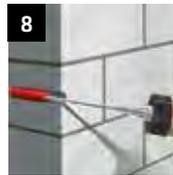
**8** Vom Bohrlochgrund her Klebstoff injizieren bei gleichzeitigem langsamem Zurückziehen des Statikmischers. Lufteinschlüsse sind in jedem Fall zu vermeiden.
